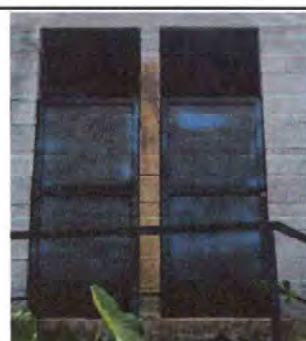
Foto 4: Sustitución de puertas de metal para baño por deterioro.
